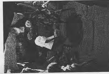
Figure 8.1.4 : Préparation de l'argile. La pâte est homogénéisée par piétinement.
