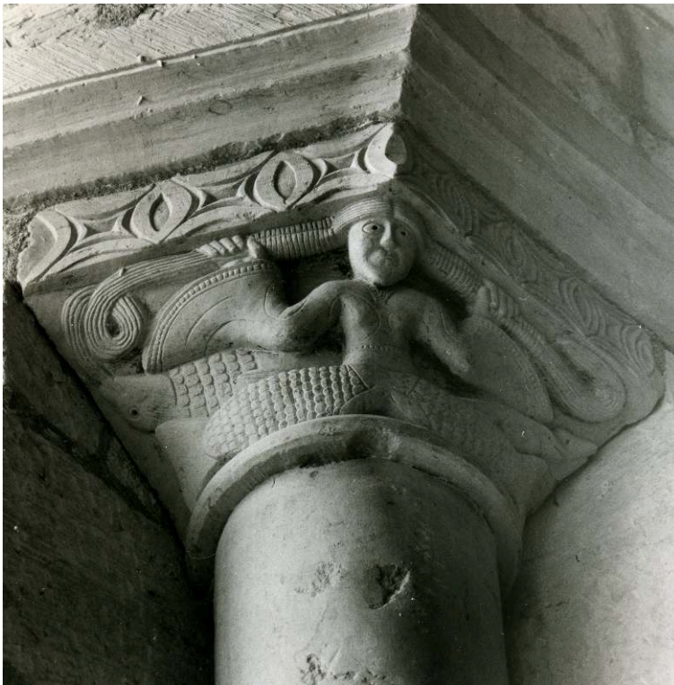
Fig. 10. - Plaimpied-Givaudins (Cher), ancienne abbatale Saint-Martin. Abside, fenêtre d'axe, après 1125.
