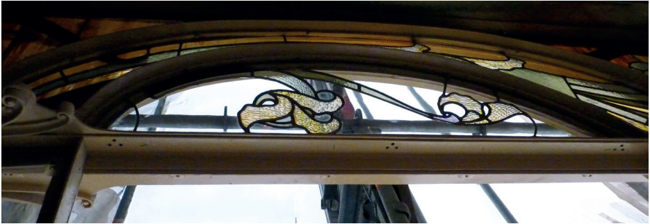
Fig. 2 - Détail des vitraux du lanterneau derrière un échafaudage installé pour le démontage de la serre.
