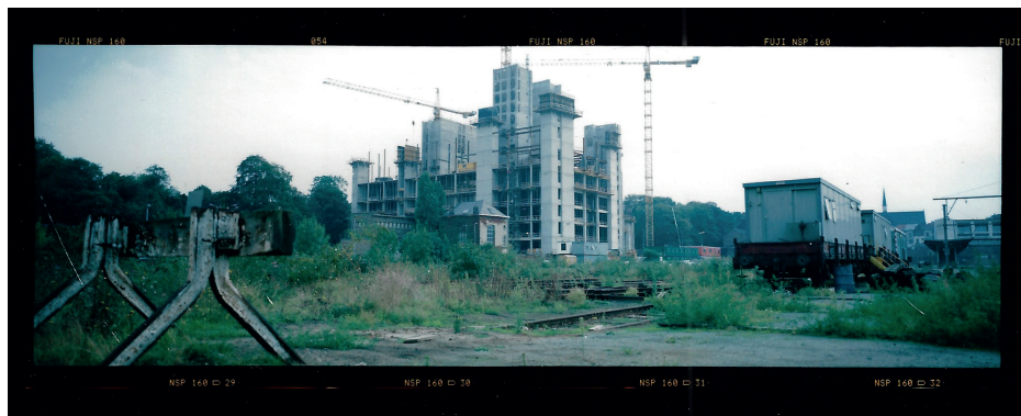
Chantier du Parlement européen. Planche contact n° 2309 du 28-09-1990. Photo de Jacques Stuyck.
