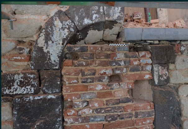
Fenêtre du premier étage perçant le pignon sud de l'aile orientale du cloître, lors des travaux de façade. MRAH – 2014 © Urban.Brussels.
