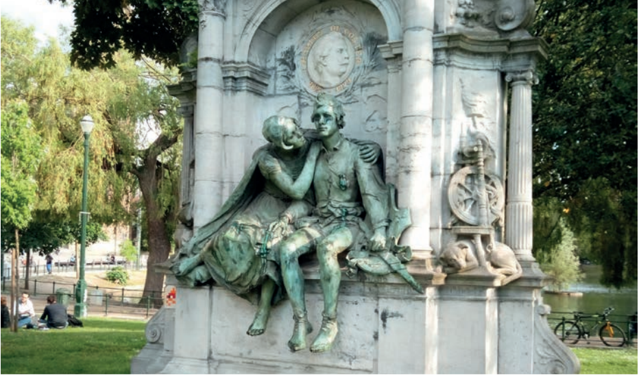
Monument à Charles De Coster, aux étangs d'Ixelles, par le sculpteur Charles Samuel, et l'architecte Franz De Vestel, 1894. Photo ©SRAB
