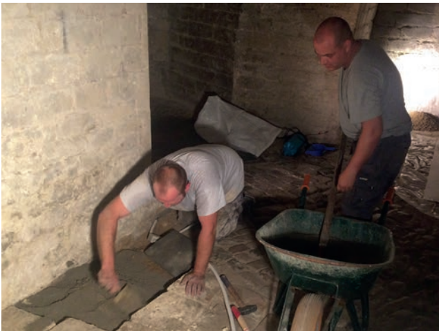
Opération de repose du dallage dans un lit de sable stabilisé par les opérateurs de la SRAB, Frédéric Légat et Laurent Benois.
