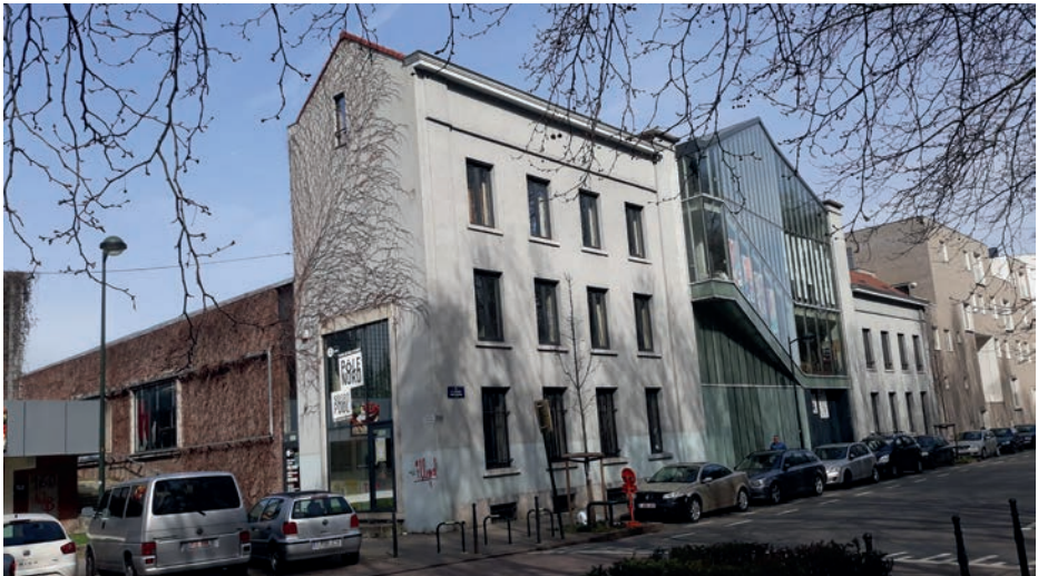
Fig. 3 - Façade de l'ancien Brussels Rinking.
