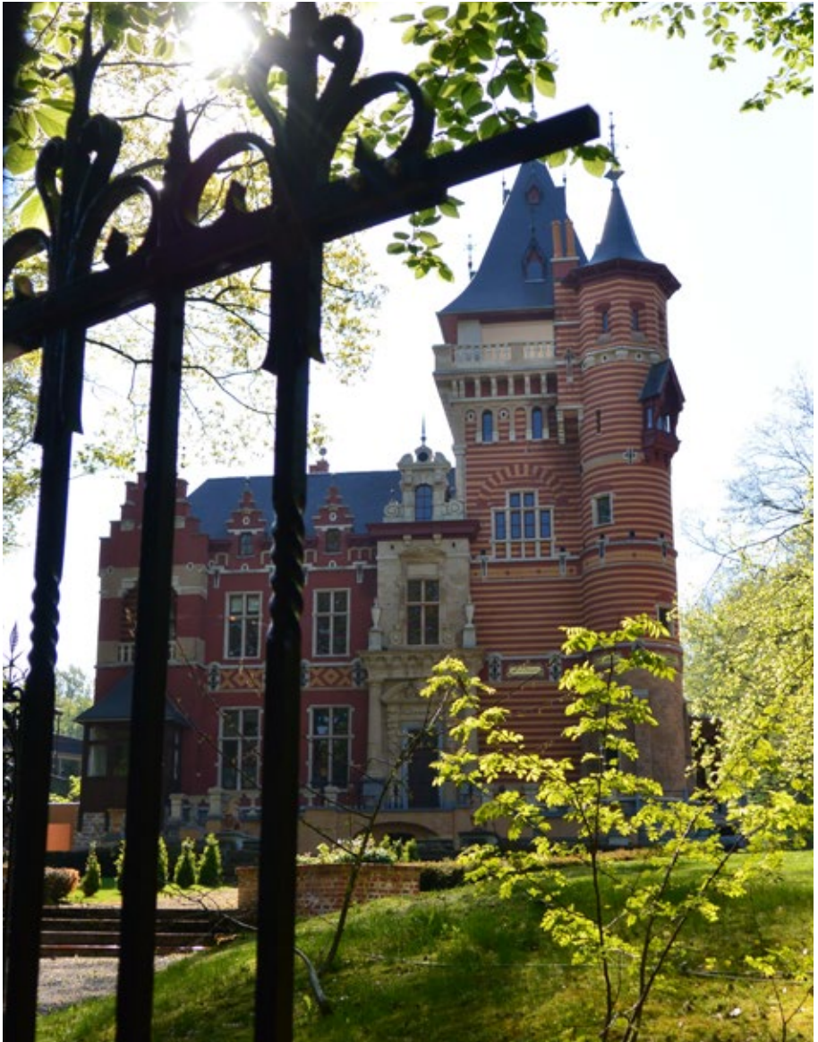
Fig. 1 - Vue actuelle du château Charle-Albert. Suite aux récentes restaurations d'envergure, la polychromie, les formes et les matériaux ont été recomposés "à l'identique", là où ils manquaient.
