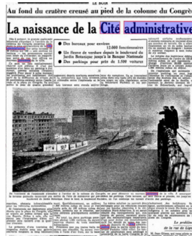
FIG. 13 L'esplanade de la Cité en cours de construction, extrait du journal Le Soir, 8 janvier 1961 (© KBR).
