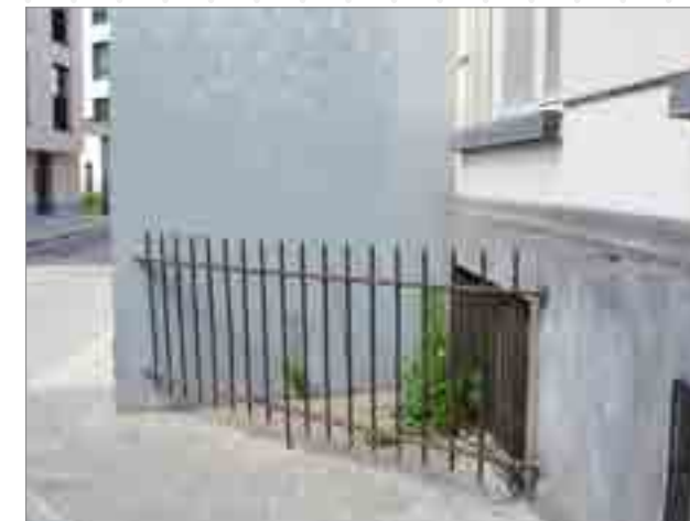
▲ Exemple de grille empêche-pipi à l'emplacement d'une rupture d'alignement. Rue de l'Arbre Bénit 32.
