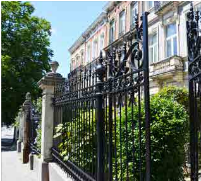
◀ Exemple de grille de clôture d'une zone de recul. Rue Vautier.
