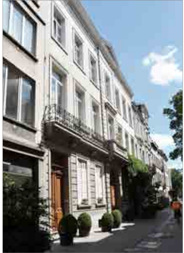
1 Rue Keyenveld 40, 42, 44. Ancienne Manufacture royale de pianos François Berden & Cie. Cette façade monumentale de sept travées réalisée vers 1870 par François Berden permettait d'accéder, via la porte cochère, à sa célèbre manufacture qui s'étendait en intérieur d'îlot. L'architecture évoque celle d'un hôtel particulier : porte cochère, balcons (un balcon central à balustres flanqué de balcons continus à garde-corps en fonte), fronton couronnant la travée centrale elle-même traitée en ressaut et munie d'un bossage aux angles évoquant des pilastres.
