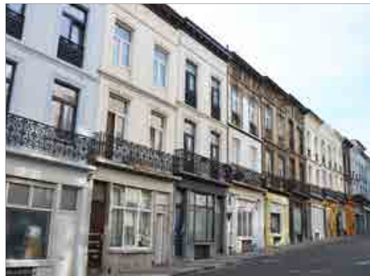
▲ Chaussée d'Ixelles n°s 257 à 229.
