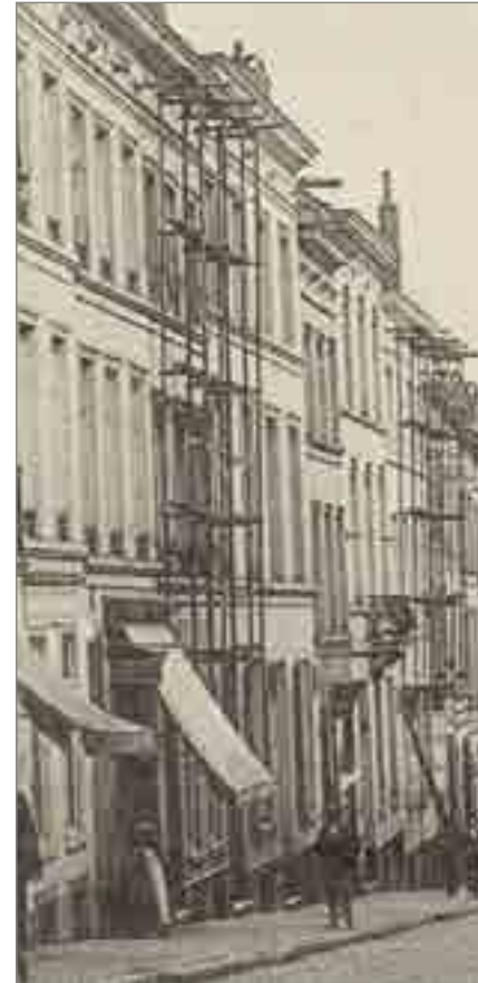
▲ Exemple d'échafaudage suspendu à partir des boulins (détail d'une carte postale de la chaussée d'Ixelles reproduite en début de chapitre). © Collection Belfius.
