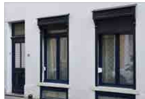
▲ Exemple de volets roulants remontant dans une caisse. Rue du Président 50.
