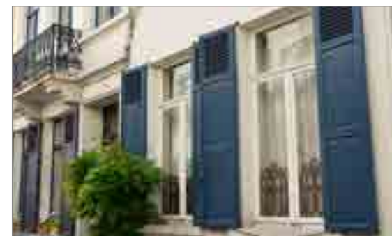
▲ Exemple de volets se rabattant contre le mur (contrevents). Rue du Président 23.
