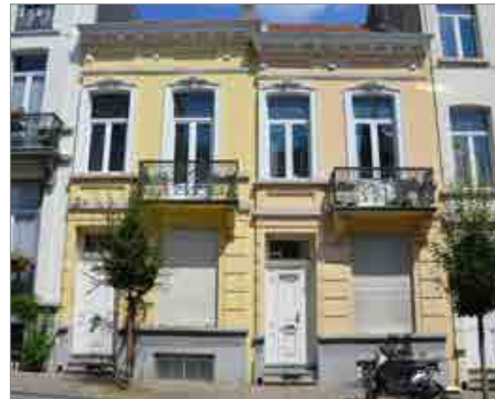
▲ Rue Maes 48 et 50 (1886). Ensemble de deux maisons de gabarit modeste mais dont le traitement de la façade est assez richement orné (ressaut, refends, balcon, corniche ouvragée) ce qui les rapproche de la demeure bourgeoise.
