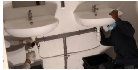
Figure 4: Début du démontage de 2 éviers sur le chantier Batiterre
