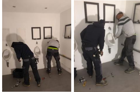
Figure 2: Démontage des pièces de commande et découpe du joint en silicone
