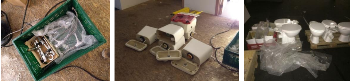
Figure 1 : WC et chasses démontées par des ouvriers pour Batiterre
