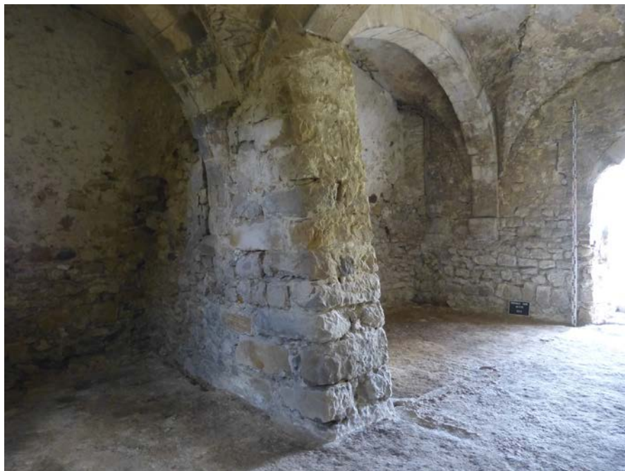
Fig. 4. L'intérieur de la salle 3 avant la fouille. Le sol fait de calcaire tassé est noirci de place en place et porte la trace de cloisons légères qui divisaient l'espace. On ne distingue pas la colonne emprisonnée dans le contrefort massif qui divise la pièce, mais on observe bien la retombée des arcs sur le tailloir. (F. Blary)
