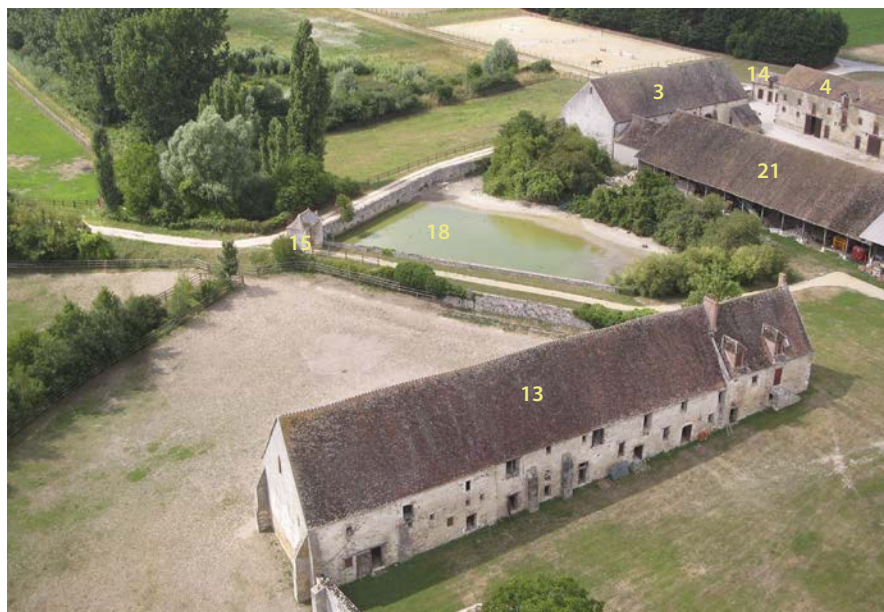
Fig. 1. La Grange des Beauvais (bâtiment 13) dans son environnement.
