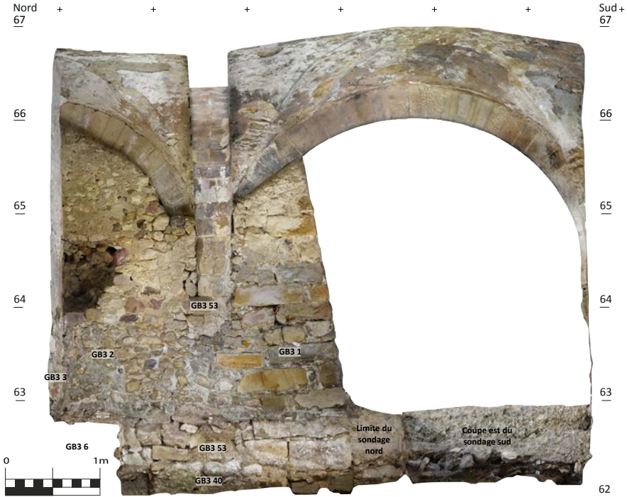
Fig. 13. Orthophotographie de la face ouest du mur de refend de la salle 3.
