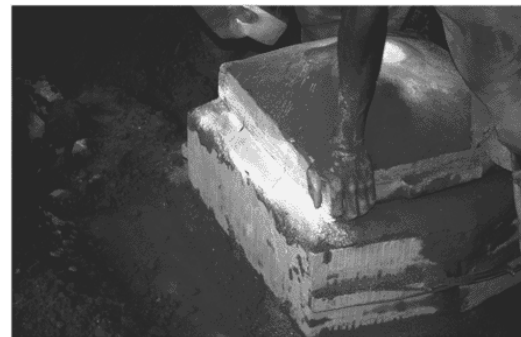
Figure II-23 Repérage de la position du cadre supérieur
