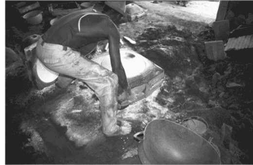
Figure II-28 Pose du second cadre inférieur
