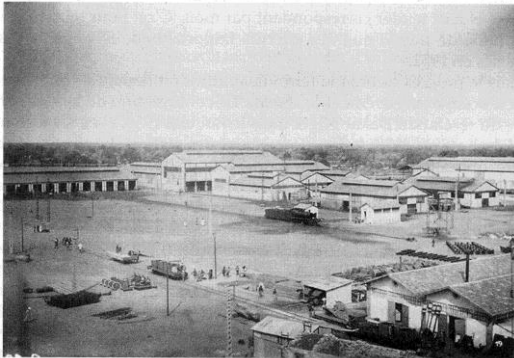
Figure IV-1 Les ateliers du Dakar-Niger à Thiès
