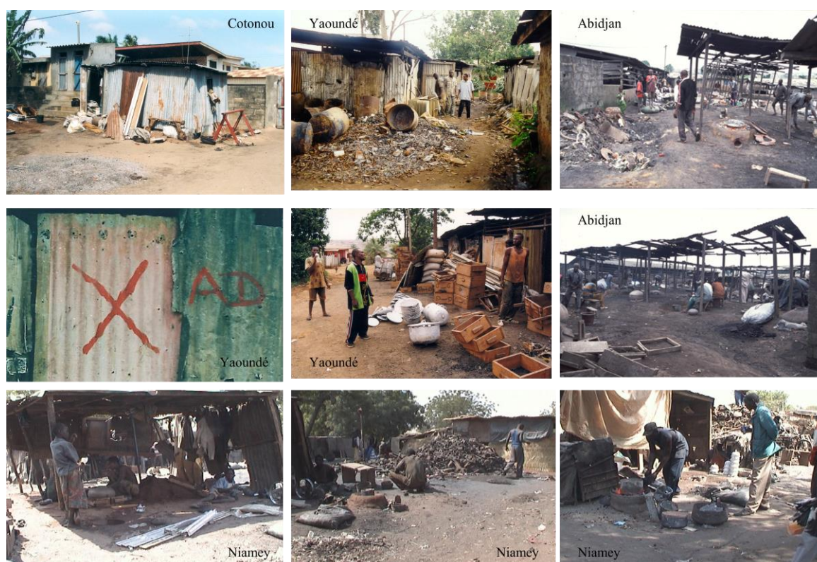
Figure II-31 Les ateliers sont construits de façon précaire
