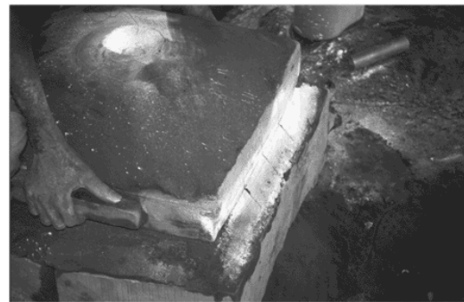
Figure II-29 Pose du cadre supérieur
