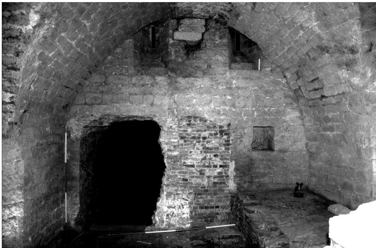
Fig. 3 : Vue partielle des caves du corps de logis du château du Coudenberg (© Société royale d'Archéologie de Bruxelles). Derrière les voûtes et les pilastres ajoutés au XIV e siècle, on distingue le mur septentrional qui délimitait le bâtiment lors de la première phase de construction datée, au plus tôt, du XI e siècle. Les deux fenêtres étroites étaient tournées vers l'extérieur où elles affleuraient au ras du sol en assurant la ventilation et l'éclairage de la cave.
