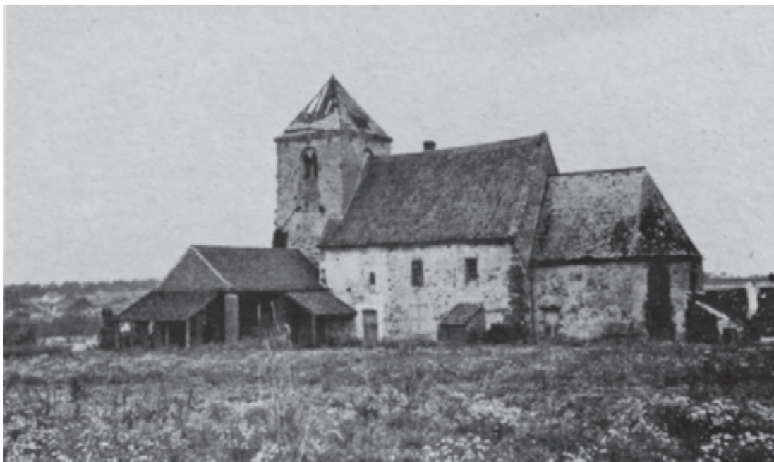
Fig. 13. Carte postale montrant la chapelle Sainte-Anne depuis le sud, avant la rénovation des Madoux en 1902. Le bâtiment agricole accolé perpendiculairement au mur sud de la tour remplace un bâtiment plus élevé situé au même endroit, comme le laisse deviner l’empreinte d’une bâtière (collection Photothèque IRPA). Selon toute vraisemblance, ce bâtiment disparu apparaît sur l’aquarelle du début du XIX e siècle (voir fig. 6)
