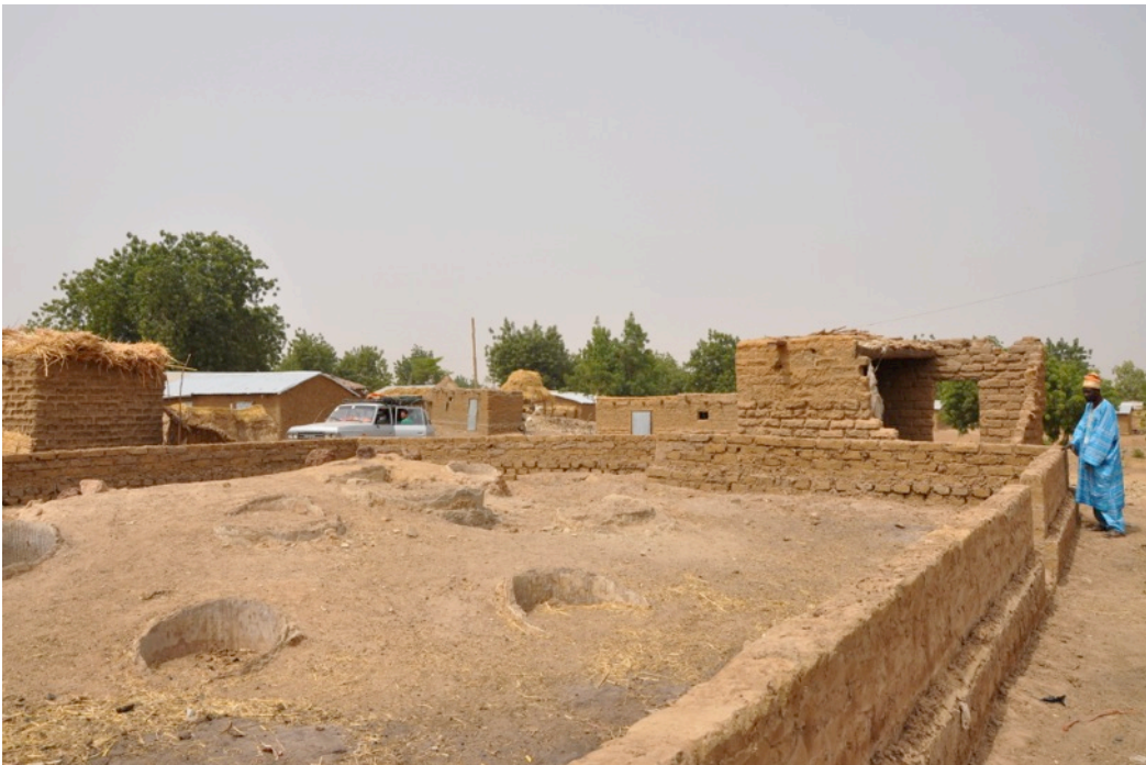
Le site de teinturerie « sinikoussou » après la construction de la première version du mur
