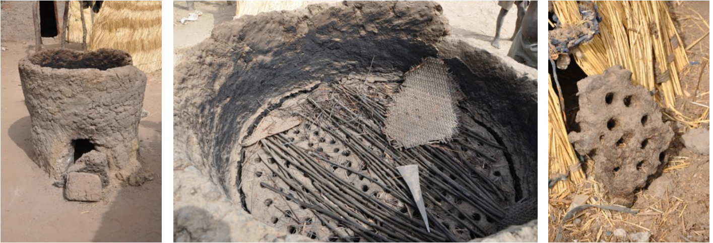
Four pour le séchage du poisson, avec détail de la sole perforée.
