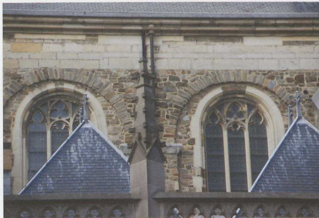
Fig. 10. Maestricht, collégiale Saint-Servais. Détail du mur goutterot méridional de la nef, montrant les transformations du XV e siècle, en tuffeau, apportées à la structure ottonienne, en grès : fenêtres, arcs-boutants et surhaussement du mur
